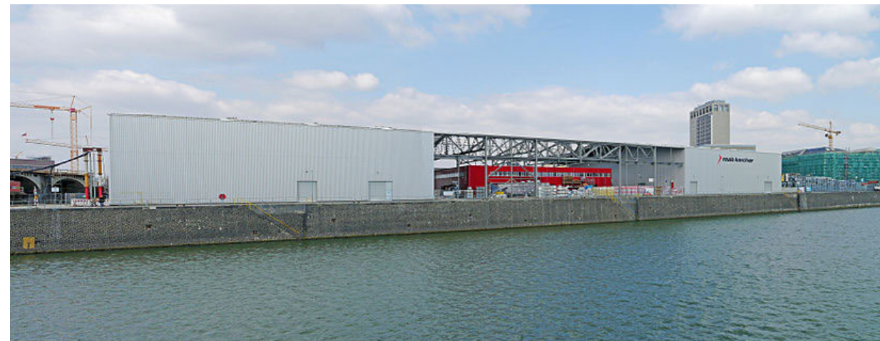
Raab Karcher Niederlassung, 2013 am Osthafen in Frankfurt am Main Rückseite der Niederlassung von Raab-Karcher', am Vorbecken des Osthafen
