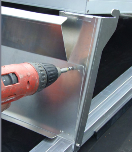
Detail hinterer Modulträger
