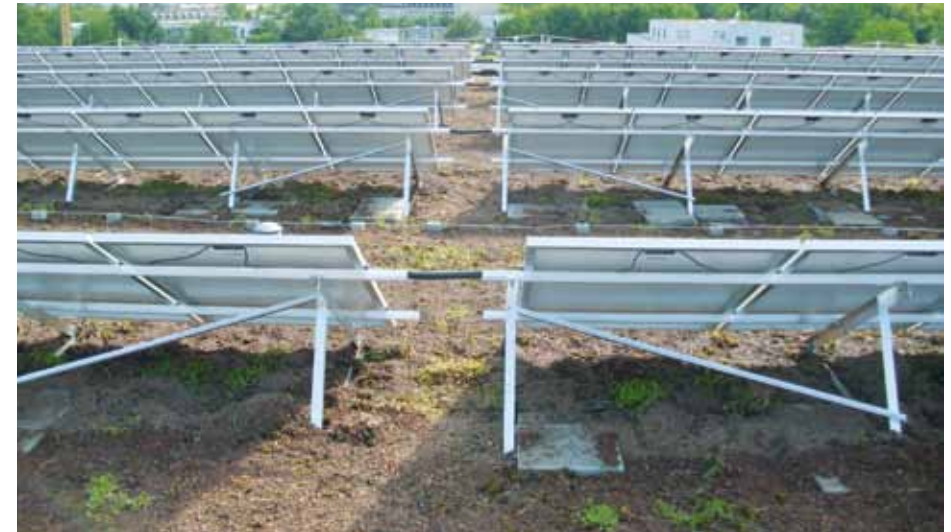
Tittmann Solar | Staatstheater Stuttgart - Deutschland Anlage: 112 kW | Triangle System
