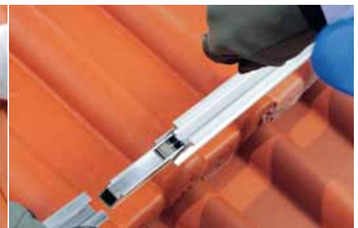
Werkzeuglose Montage des Schienenverbinders ohne Verschraubung (Klick-In).
