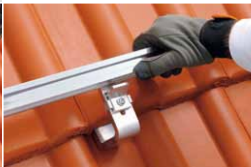
Schnelle und sichere Montage durch verdrehsichere Flügelklemmen.
